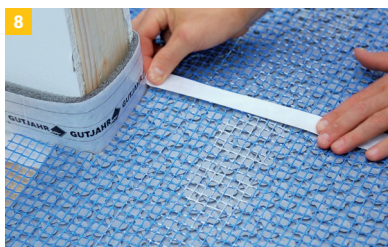
8. ...tada siūlės apsaugomos priklijuojant Watec® BW arba lipnią popieriaus juostą, kad tarp lakštų nepatektų plytelių klijai. Įrengtos lankščios siūlės turi būti atkartotos ant plytelių /akmens dangos.
