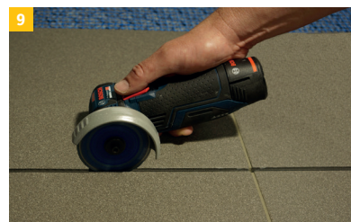
9. Jeigu deformacinės siūlės įrengiamos po plytelių suklijavimą, IndorTec FLEXBONE® 2E prapjaunamas per visą siūlės plotį.
