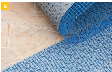
5. Lakštų kraštai turi būti priglundę vienas prie kito. Atskiri lakštai sujungiami lipnia užlaida, esančia ant ilgosios lakšto kraštinės.
