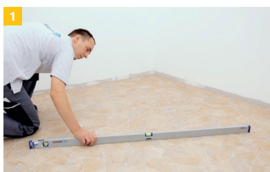
1. Pagrindas turi būti tinkamas ir lygus. Reikalui esant, jis išlyginamas ARDEX mišiniais.
