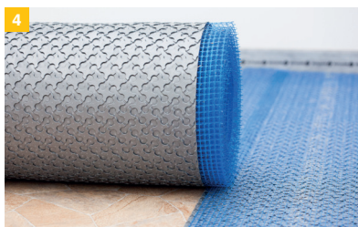
4. ... supjaustyti pagal reikiamą ilgį IndorTec FLEXBONE® 2E rulonai/lakštai patiesiami ant pagrindo vienas priešais kitą.
