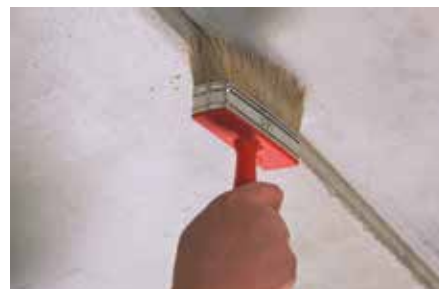
Ant betono, prieš gipsinius glaistus, ARDEX P 51 skiedžiamas su vandeniu (1:3)
