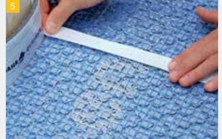
Ant deformacinių siūlių užklijuojama Watec® BW juosta, kad į siūles nepatektų klijų.
