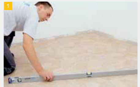
Pagrindas turi būti tinkamas ir lygus. Reikalui esant, jis išlyginamas ARDEX mišiniais.
