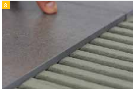
Ant klijais užpildytų lakštų plytelės klijuojamos tais pačiais klijais "šviežias ant šviežio".
