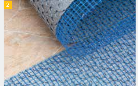
Lakštai klojami vienas prie kito ir sujungiami lipnia užlaida esančia ant ilgosios kraštinės.
