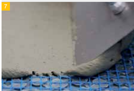
IndorTec® 2E lakštų ertmės užpildomos ARDEX X 78, X 90 arba S 28 plytelių klijais.
