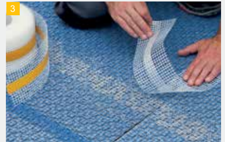
Trumposios kraštinės ir perpjautos vietos sujungiamos su lipnia Watec® ST juosta.
