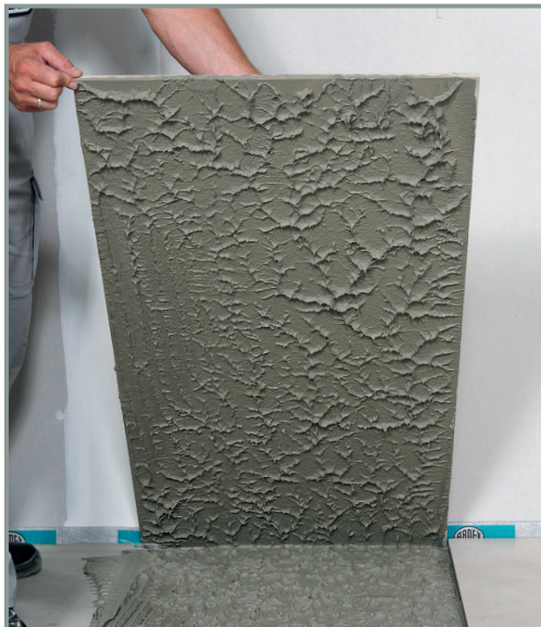
ARDEX MICROTEC X 78: pilnas klijuojamo paviršiaus padengimas klijais.
