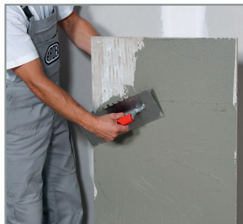
Geresnis sukibimas: su ARDEX MICROTEC serijos X 78 arba S 28 klijais. Rekomenduojama padengti klijais ir klijuojamą plytelės paviršius.
