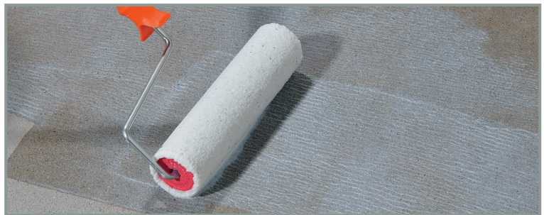
ARDEX P 51 drėgmę blokuojantis gruntas: ant gipsinių pagrindų skiedžiamas su vandeniu, santykiu 1 : 3.
